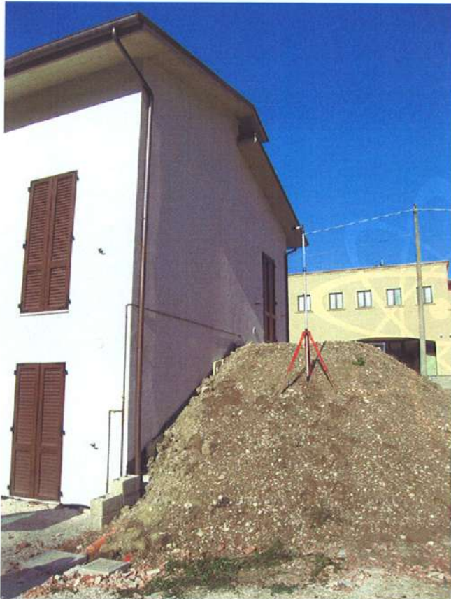
Fotografia della facciata esterna dell'edificio.
