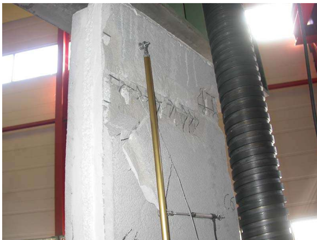
Figura 17: Instabilizzazione dell'armatura compressa
