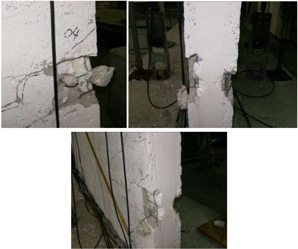
Figura 33 Danneggiamento al termine dell'imposizione dei tre cicli a livello di drift 0.6%
