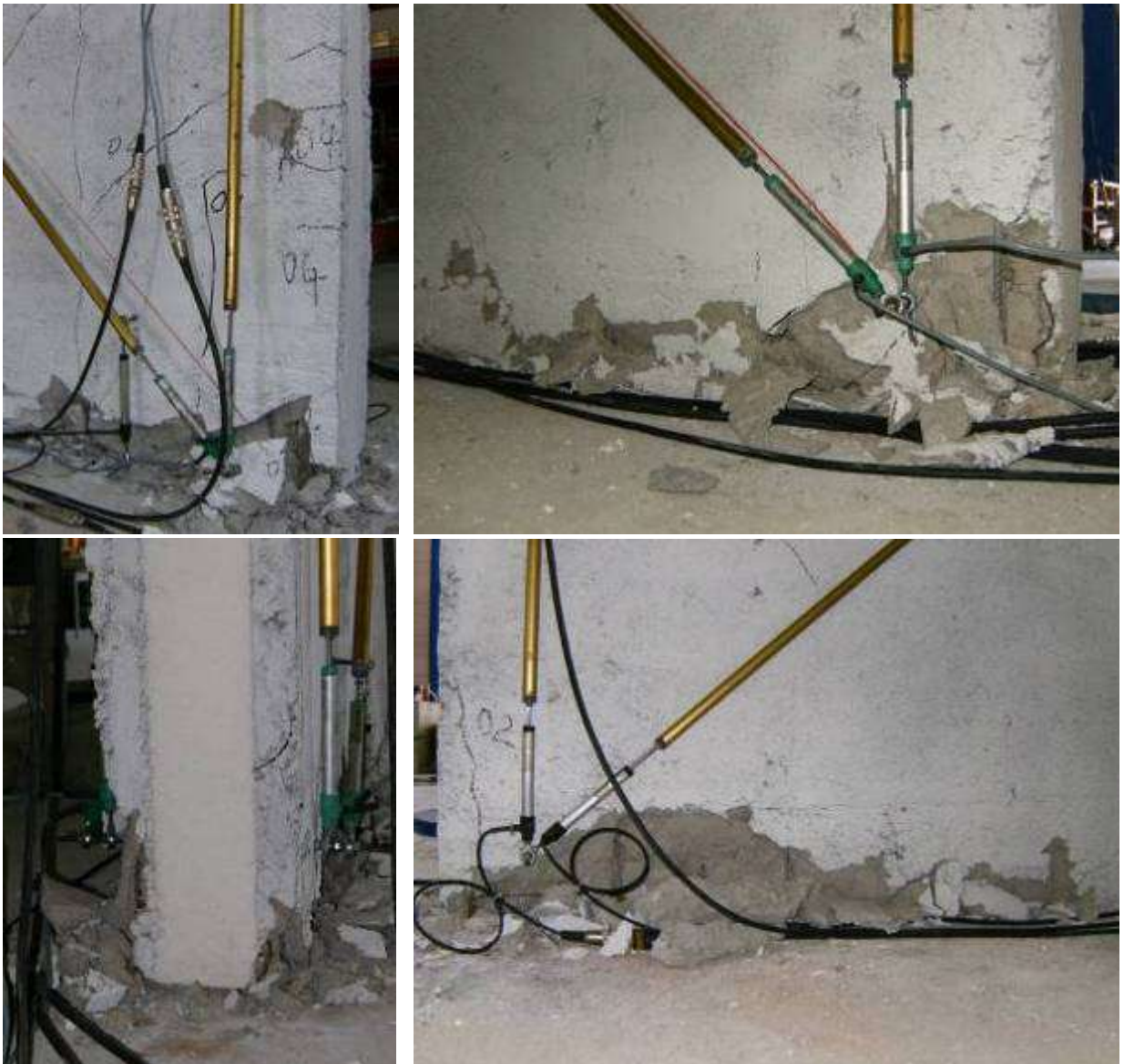
Figura 24 Danneggiamento al termine dell'imposizione del ciclo al livello di drift 1.5%
