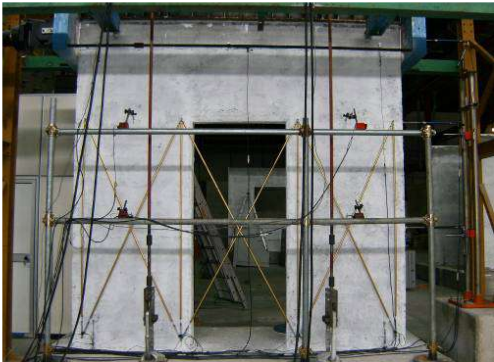
Figura 74 Danneggiamento al termine dell'imposizione dei tre cicli a livello di drift 0.1%
